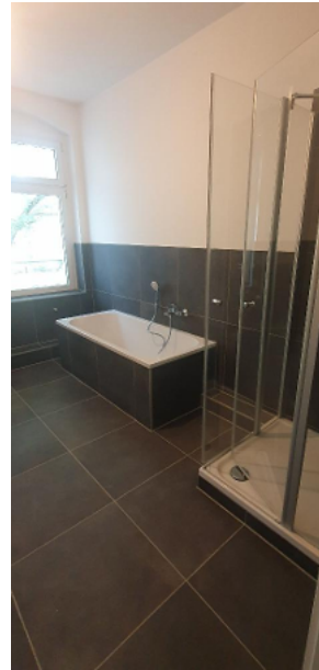
Bad Wanne Dusche
