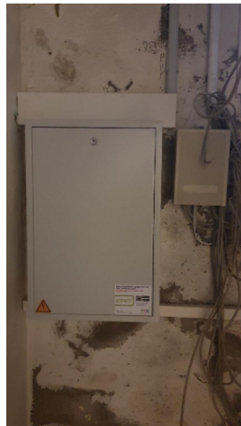
Telekom/Püyr-Anschlusskasten
