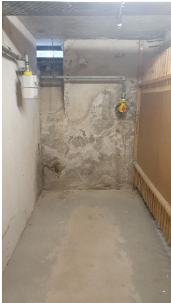
Gaszähler/ Gashauptzuleitung
