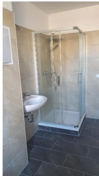
Dusche mit Regendusche
